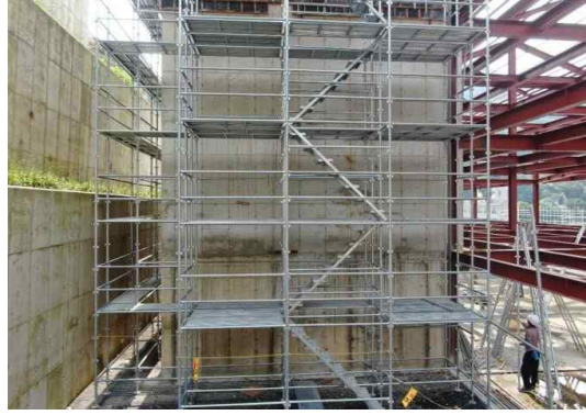
<그림 29> 안전난간설치 예
