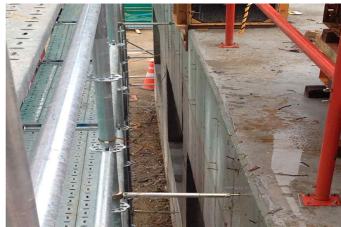
<그림 25> 벽연결재 설치
