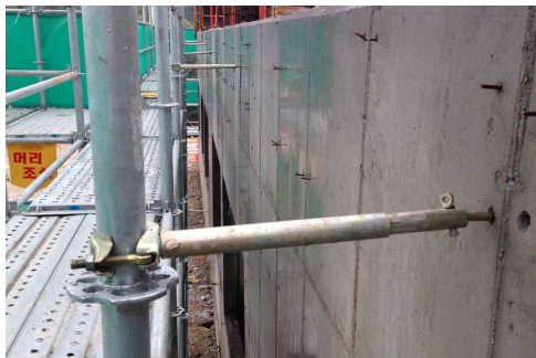
<그림 25> 벽연결재 설치
