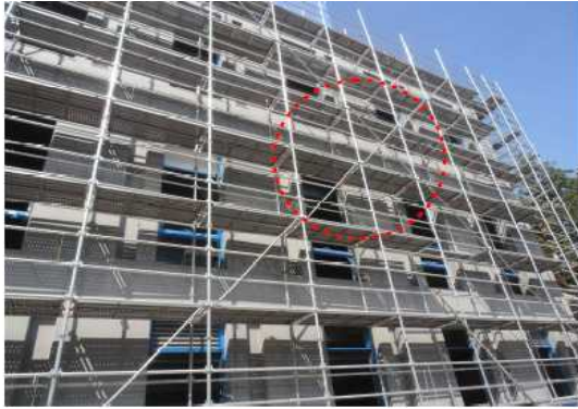
<그림 26> 가새재 설치 예시
