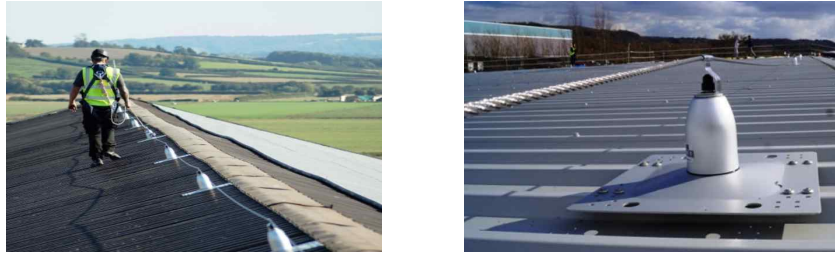
<그림 21> 경사진 지붕에서의 안전대 부착설비 설치 예
