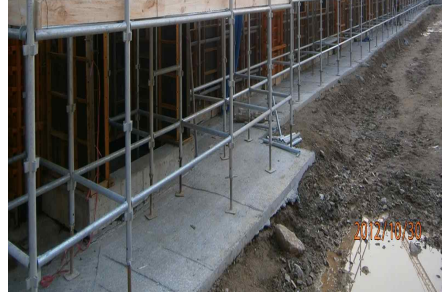
<그림 24> 콘크리트 타설
