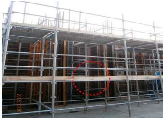
<그림 30> 발끝막이판 설치 예
