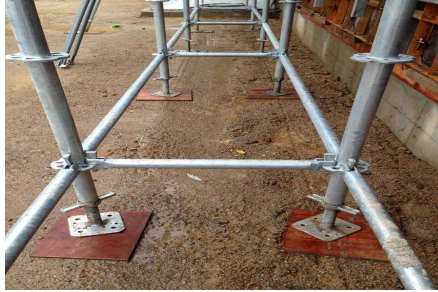
<그림 23> 깔판 설치
