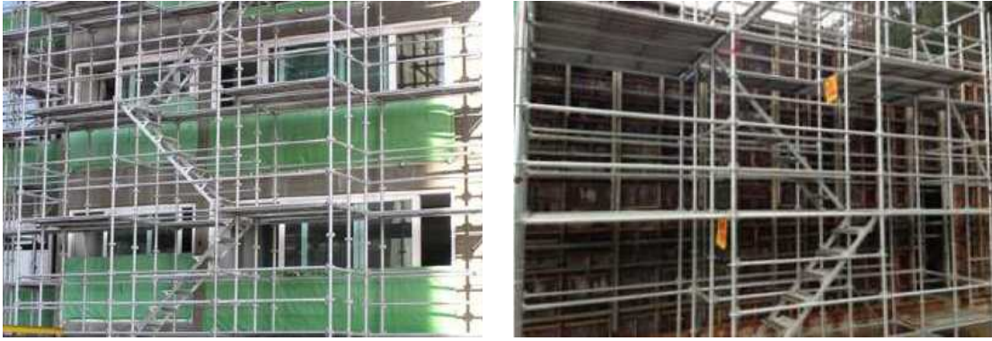
<그림 31> 가설계단 설치 예
