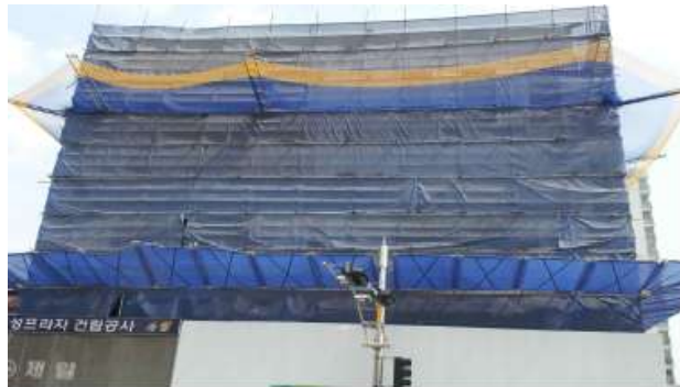
<그림 32> 낙하물 방지망 및 수직보호망 설치 예
