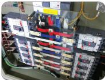
<그림 12> 변전실 패널의 충전부 접촉에 의한 감전사고 예방대책
