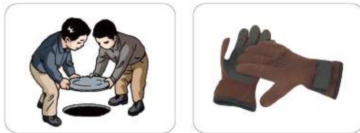
<그림 5> 맨홀 뚜껑에 손가락이 끼이는 사고 예방대책
